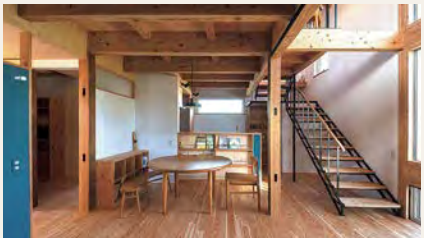
天井や梁、柱など道産カラマツの構造材が見える状態で仕上げた ダイナミックな木組の空間で、時とともに色濃くなる経年変化を楽 しめる。(武部建設×アトリエmomo)
