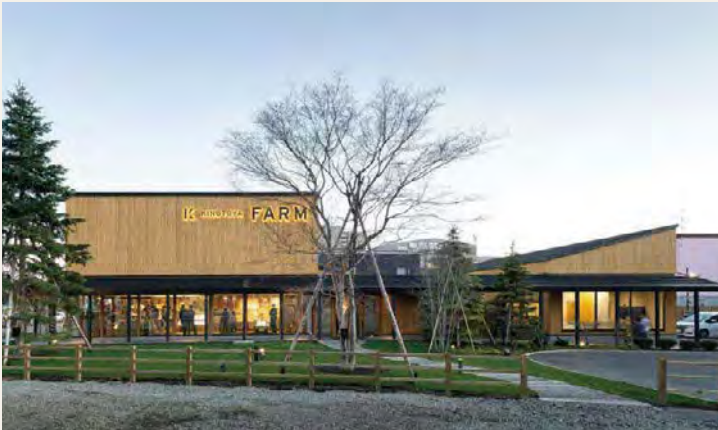
外壁や、内装の天井に道南杉材を使用。 農風景がゆるやかに地域に溶け込むようなアプローチで、お店に入るまでも楽しい。
